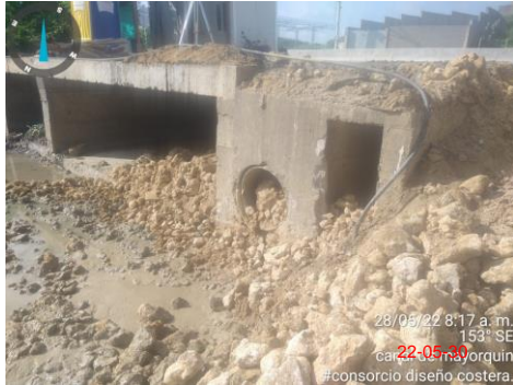
Foto 1. Remoción piedras que obstruyen Canal.
