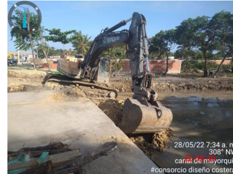
Foto 2. Conformación capa pedraplén.
