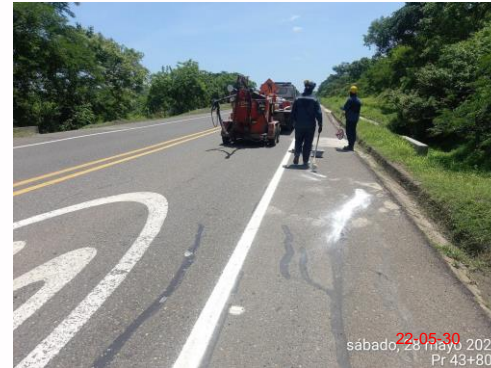
Foto 4. Ruteo, sello y cal en fisuras en asfalto.
