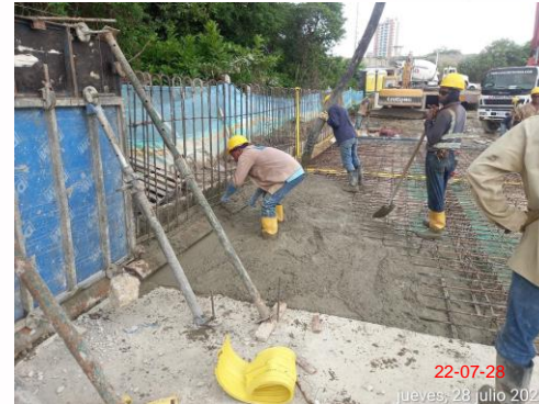
Foto 4. Vaciado placas módulos 06-07.
