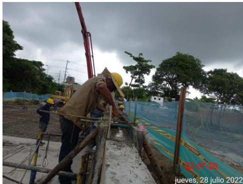
Foto 3. Vaciado muros módulo 08.
