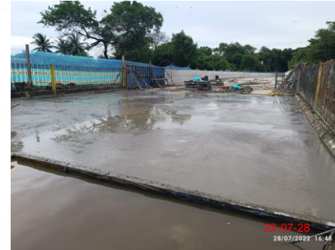
Foto 2. Vaciado placas módulos 06-07.
