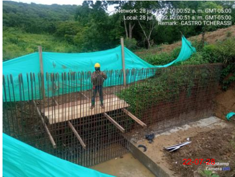
Foto 1. Instalación aceros horizontal muros del parqueadero.
