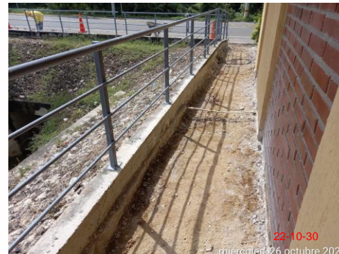
Foto 4. Demolición andén área baños y parqueadero.
