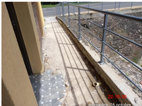
Foto 3. Demolición andén área baños y parqueadero.
