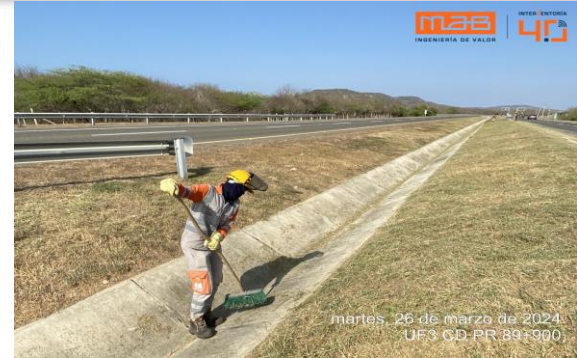
Foto 2. UF3 Separador central PR 89+900 - Labores de rocería.
